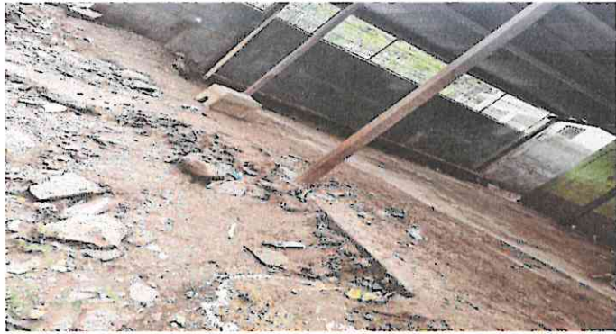
Foto1: Cambio de Costaneras.
