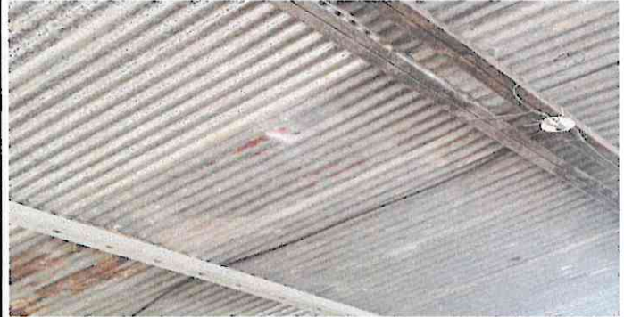
Foto 2: Cambio de láminas por láminas troqueladas.
